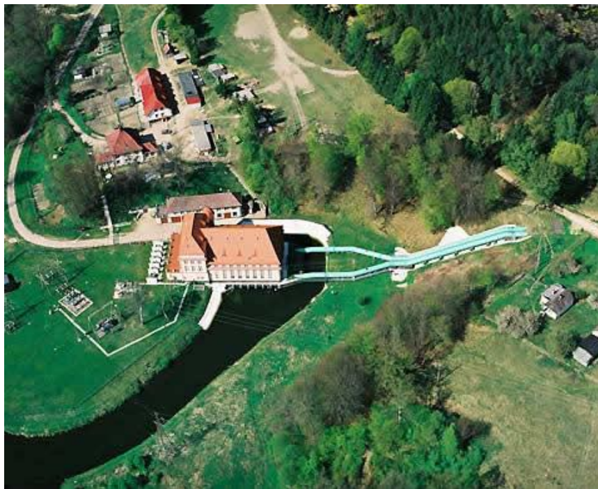
Elektrownia wodna w Gałęzi Małej[9]
