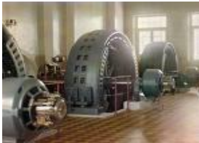
Generator w elektrowni wodnej
