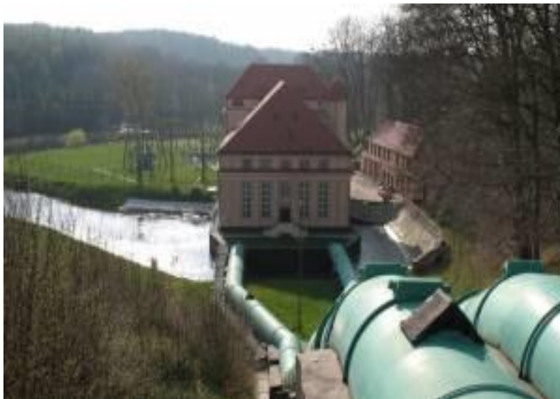
Mała elektrownia o mocy 3,5 MW w Gałęzi Małej [3]
